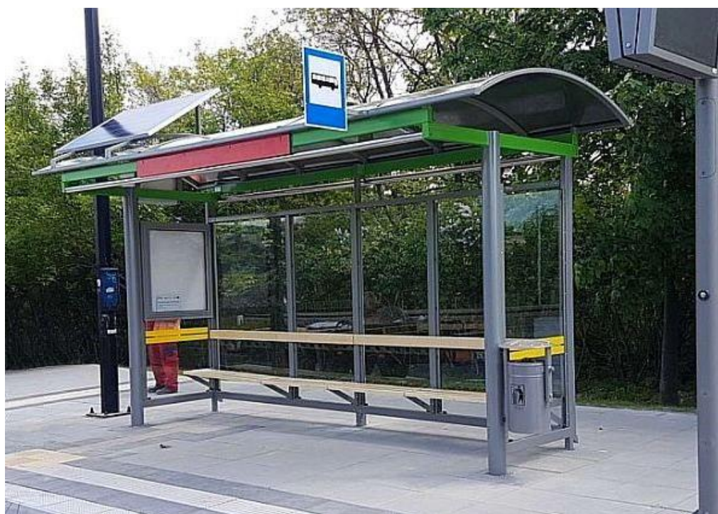
Rysunek 3 Wyposażenie w fotowoltaikę
